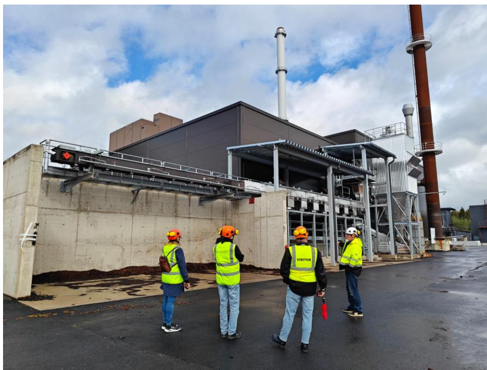
Biokolanläggningen sedd från utsidan. Huvudanläggningen inne i den mörkgrå byggnaden.
