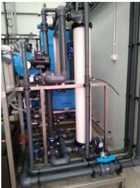
Figur 4 Membranfiltret finns i den lodräta cylindern till höger
