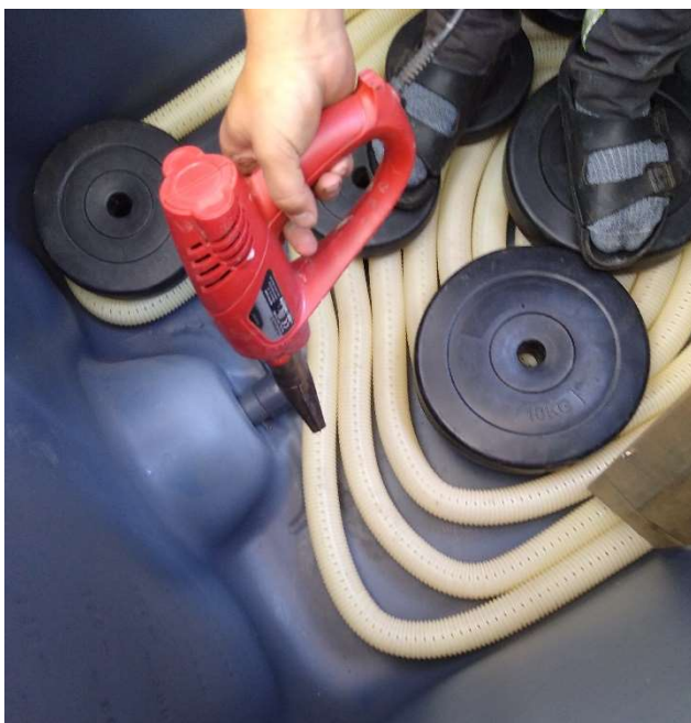
Figur 1 Värmeblåsare användes för att få slangen att hållas böjd och vikter användes för att hålla slangen på plats under arbetet.
