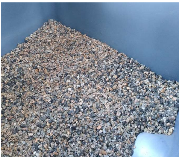
Figur 2 Ovanpå dräneringslangen lades grus.
